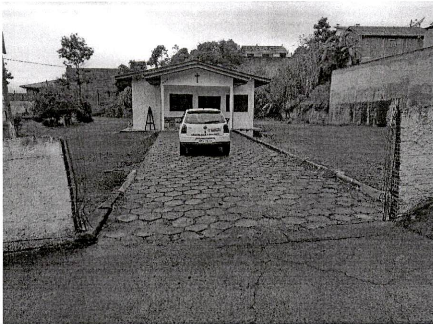
Foto 2 – Vão de acesso com muro a ser reformado e colocação de grades no vão
