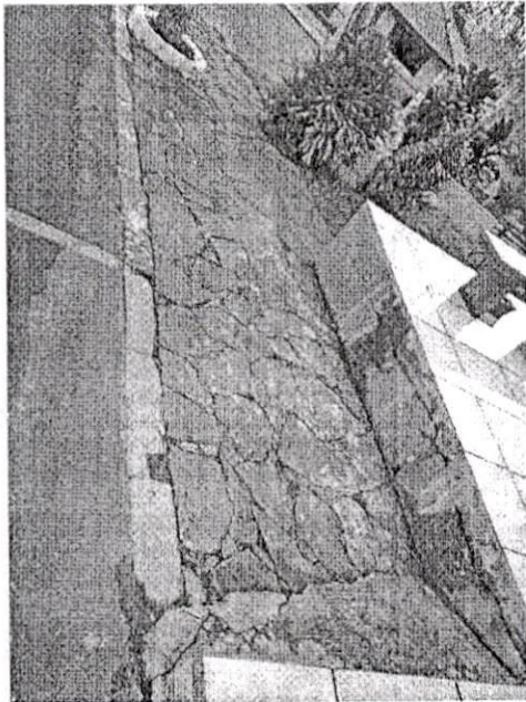
Foto 2 – Passeios no acesso
