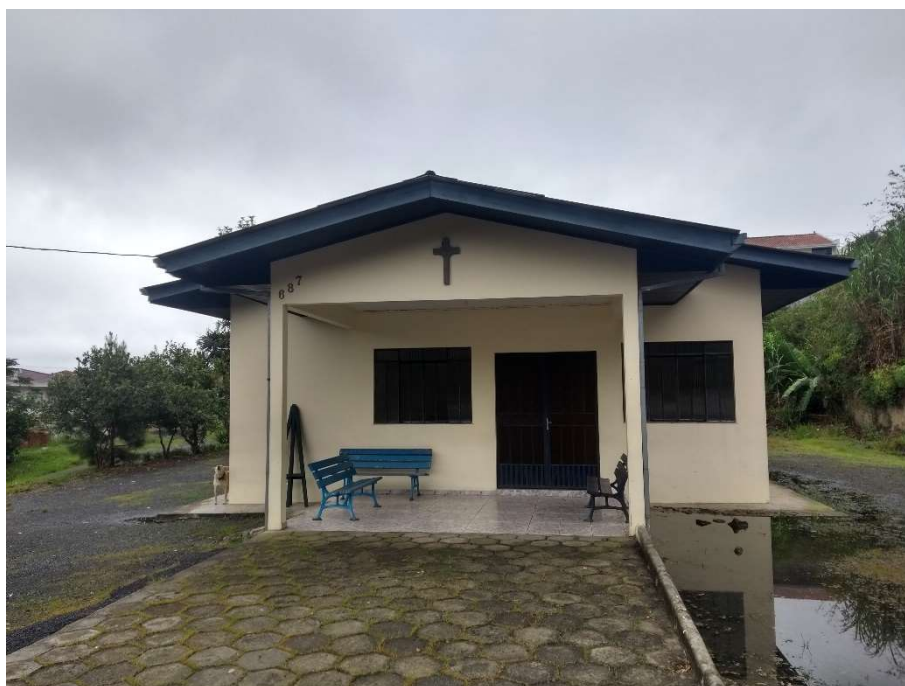
Foto 1 – Fachada Frontal da Edificação
